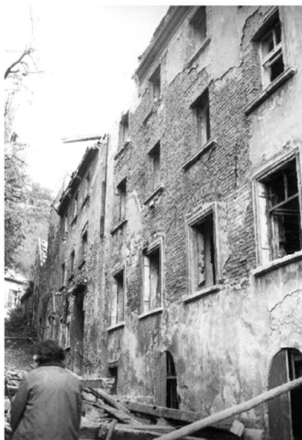
Východná strana Štukovej ulice počas búrania (1968).
