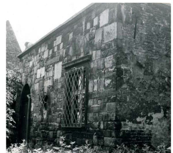
Nová budova Bet ha Kneset, detail fasády a okennej mreže.
