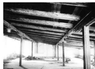
Dom č. 44, priestory erárneho proviantného skladu z 18. storočia (1969).
