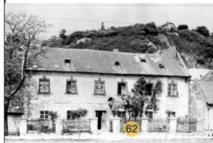
Dom č. 62 na Podhradskom nábreží, tzv. Münzhaus patril k "erbovým" domom Zuckermandla. Vyznačoval sa najmä typickými barokovými košovými kovanými mrežami na oknách a oplotenou ozdobnou predzáhradkou (1958).
