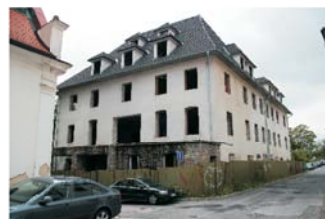
Objekt bývalého hostinca U čierneho medveda po nadstavbe v roku 2002. Rohu Trokanovej a Žižkovej ulice (2013).
