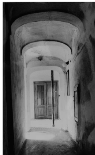
Chodba s barokovými klenbami na poschodí domu č. 33 na Žižkovej ulici.
