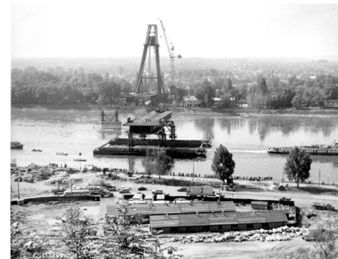
Výstavba Mosta SNP, pripojenie nového mostného poľa (1971).
