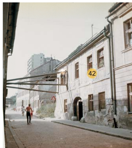
Dom č. 42 na Žižkovej ulici. Historická zástavba (1967)
