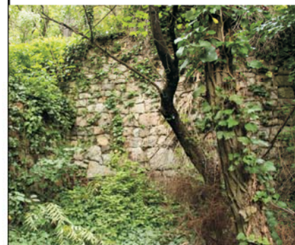
Zvyšok zájazdného hostinca v bývalom kameňolome.
