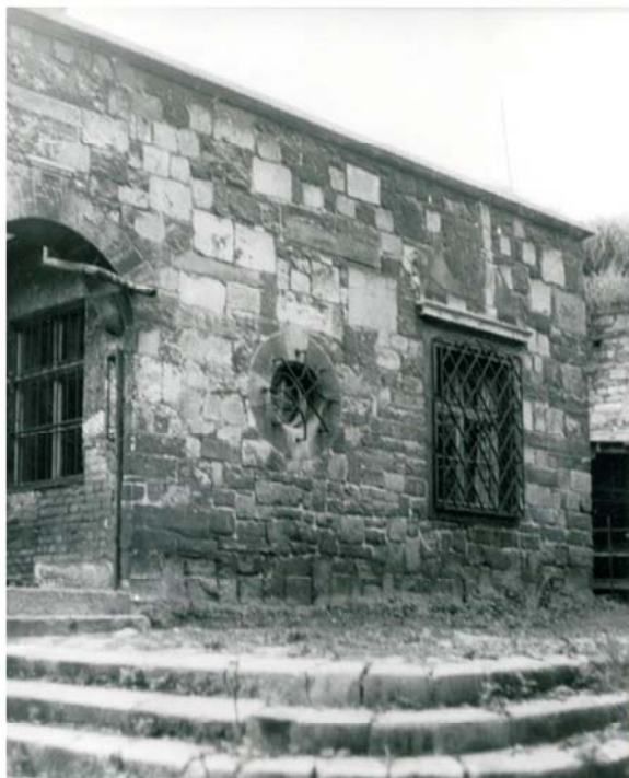
Nová budova Bet ha Kneset (Dom zhromaždenia) bola postavená v roku 1925 v areáli Schulhofu podľa projektu od A. Szalatnaia-Slatinského z roku 1922.
