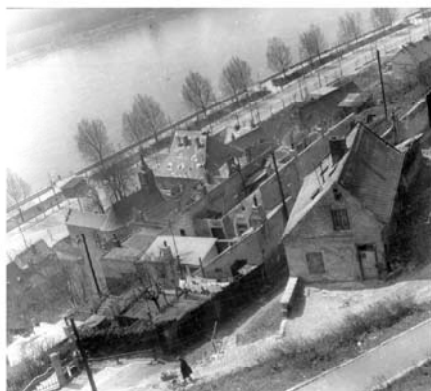
Pohľad z hradu na Bubenkovu ulicu a zástavbu okolo Kostola Najsvätejšej Trojice pri Dunaji na Žižkovej ulici (1970).
