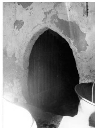
Vydrlica, dom č. 29. Gotický kamenný portál, vstup do pivnice (1968).
