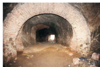
Skalný priestor pri dome č. 12. Klenba haly vysekaná do skaly bola spevnená tehlovým pásom.
